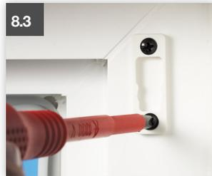
Schrauben Sie die Einhängegabel mit zwei schwarzen Schrauben fest. Zwischen Flügel und Laibung genügen 16 mm Abstand für die Einhängegabel.
