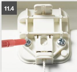
Markieren Sie die Löcher und bohren Sie die beiden Löcher beim Holz- oder Kunststofffenster ca. 13 mm tief, beim Alufenster ca. 4-5 mm tief. Befestigen Sie die Verriegelung mit den zugeordneten Schrauben.
