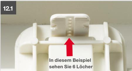
**Tipp:** Wenn Sie das ganze Gleitplättchen einsetzen, ist die Verriegelung am leisesten, verhindert diese aber zugleich. Es bleibt dadurch wahrscheinlich eine Spaltlüftung, welche in Schlafräumen gewünscht sein kann.
